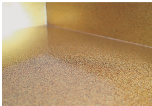
図2 見台A 抽斗内のカビ 修理後
