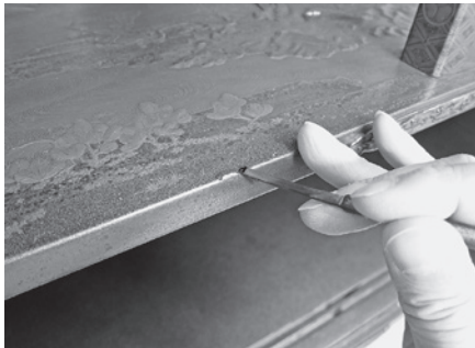
挿図11 刻苧箇所に漆下地付け作業
