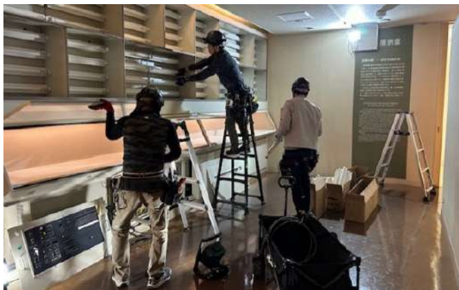
情報ラウンジ(旧第6展示室)リニューアル工事風景
